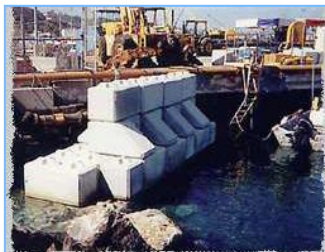
해안 구조물 공사
