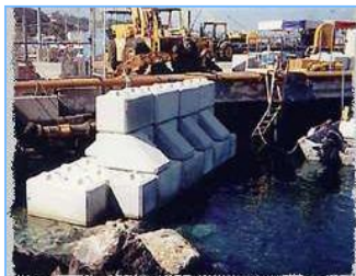
해안 구조물 공사
